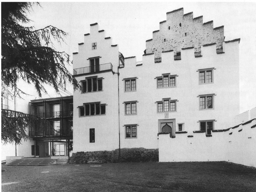
5: Nordwestansicht mit u.l.n.r.: Mitteltrakt von 1994/96 und der um 1850 in neugotischer Art umgestaltete Westtrakt; deutlich erkennbar ist die dunkle Fundamentuntermauerung von 1850 als Zeichen beträchtlicher Terrainabsenkungen (vgl. dazu auch Abb. 8).
