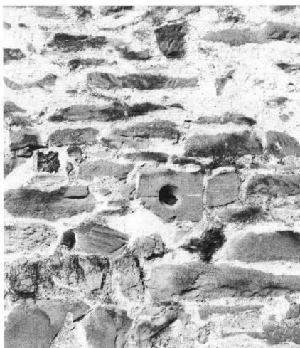
23: Wohnturm A von 1243, Südfassade im Bereiche des 2. und 3. Obergeschosses: romantisches Lochfensterchen mit eingekerbtem Zierkreis und gleich eine Steinlage höher Balkenstümpfe als Bugauflager zu einem überkragenden Obergaden.
