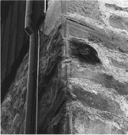
17: Wohnturm A von 1243: nordöstliche Turmecke mit Randschlag.
