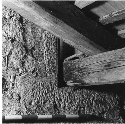
24: Wohnturm A von 1243, Ostfassade: Fensterchen zum 3. Obergeschoss und originaler Fassadenputz von 1243; seit 1850 als Dachstuhl-Auflager.
