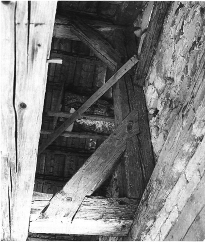
27: Wohnturm A von 1243: heutiger Dachstuhl-abbund in der Manier des ausgehenden 16./beginnenden 17. Jahrhunderts.
