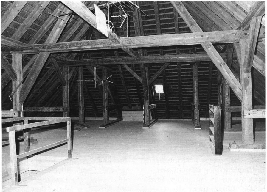
31: Osttrakt: Dachstuhl von 1885 in zeittypischem eisenschraubten Abbund.
